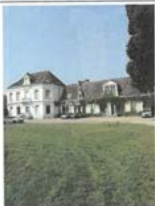
Bâti façade avant
