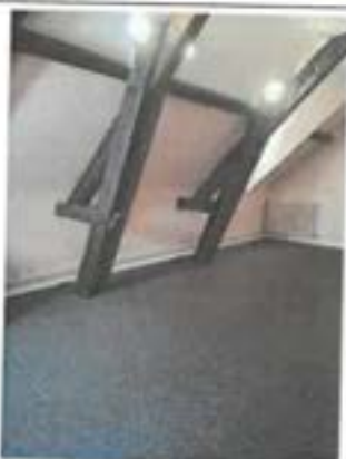
Partie des combles aménagés de la partie droite du bâti
