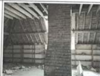
Partie des combles non aménagés (partie droite du bâti)
