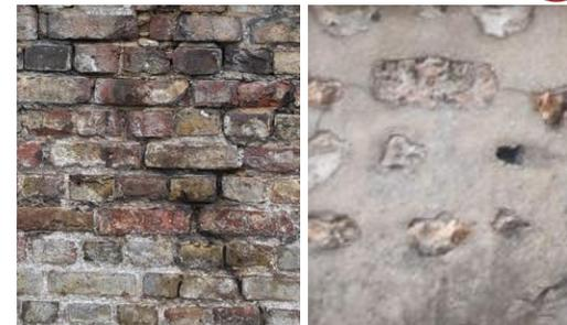
Mur humide à traiter et mur rejointoyé grossièrement à l'enduit béton. Le béton devient plus prégnant que la pierre
