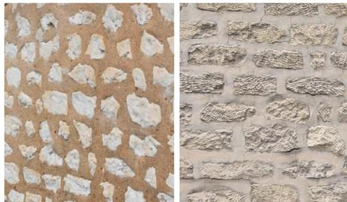
Moellons rejointoyés correctement à l'enduit à la chaux beige (à droite) et ocre (à gauche).
