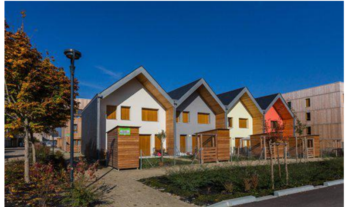
Opération d'habitat coopératif dans un écoquartier (Hameau des Noés, Val de Reuil, 27) opération menée par la Siloge.
